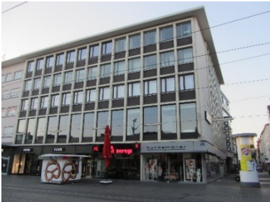
Heutiges Gebäude R 1, 1 im Juni 2018
